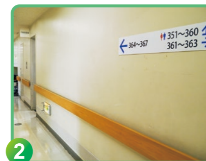
2 本館3階病棟の手すりの改修
