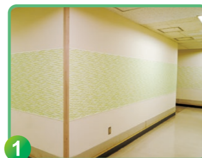
1 本館地下1階(廊下及び霊安室)の壁紙の張り替え及び扉、天井の塗装
