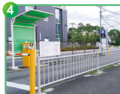
4 外来駐車場の横断防止柵の設置
