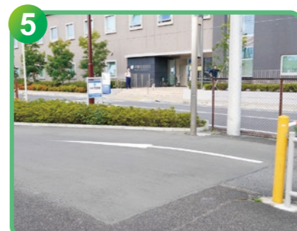
5 外来駐車場の陥没部位の舗装打ち換え
